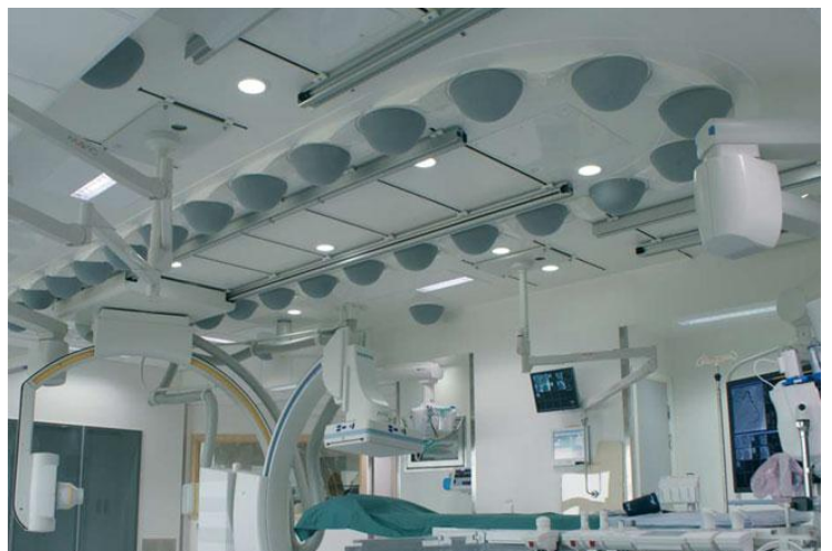
Abb. 32: Temperaturkontrollierter Airflow –Hybrid-OPs mit TAF
