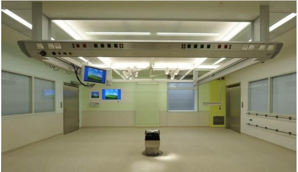
Abb. 30: Differentialflow mit Strömungsschürze und 3-seitigem Medienbalken
