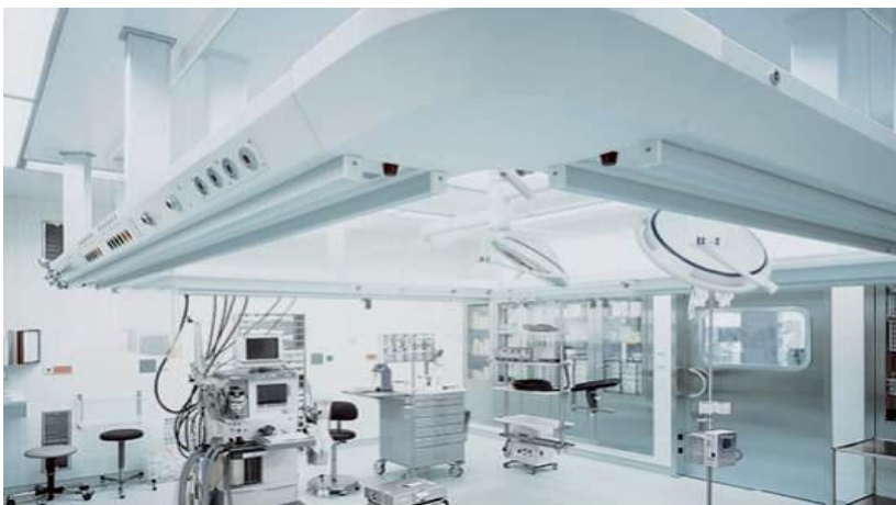
Abb. 29: TAV-Lüftungsdecke mit IS 500 OP-Medienbrücke
